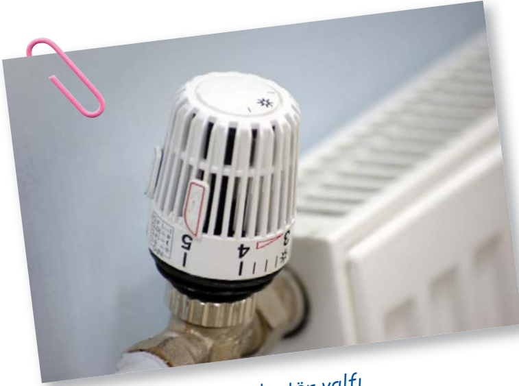
Şekil 1: termostat radyatör valfi
