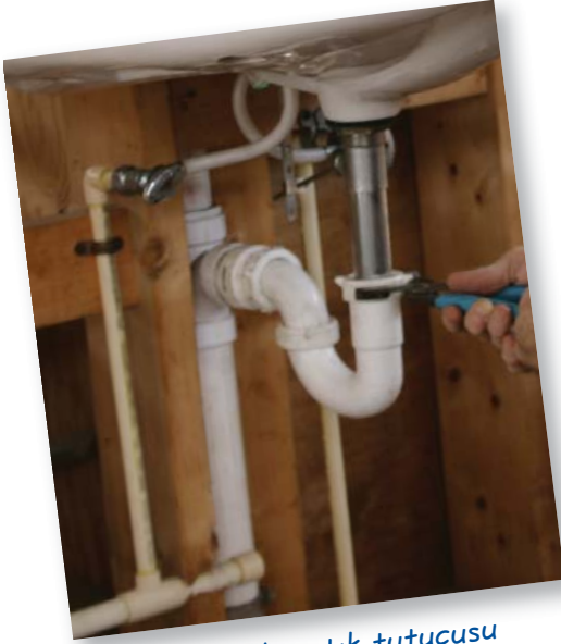
Şekil 1: lavabo atık tutucusu veya u-dirseği
