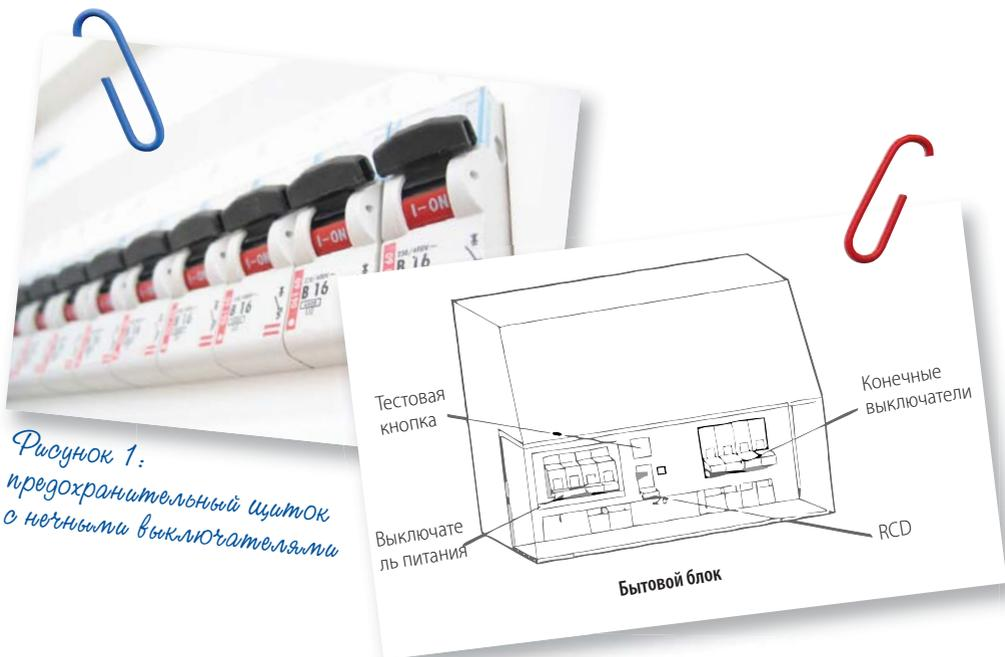
Старые предохранительные щитки содержат гнезда предохранителей, и в случае если предохранитель перегорает, его необходимо либо заменить, либо соединить заново с использованием специальной предохранительной проволоки с соответствующей силой тока. Предохранительные щитки старого типа встречаются нечасто, но если у вас именно такой, не пытайтесь починить или заменить предохранитель самостоятельно - вызовите службу аварийного ремонта вашего арендодателя.
