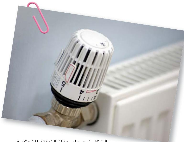
الشكل ١: صمام جهاز التدفئة للتحكم في تنظيم درجة الحرارة
